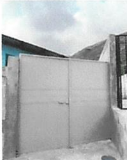
Foto 3: Mantenimiento a portones de metal
