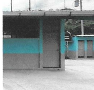
Foto 8: Mantenimiento a estructura (lijado, cambio de tubo, cepillado, sujeciones, aplicación de pintura)
