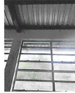
Foto 2: Sustitución de vidrios
