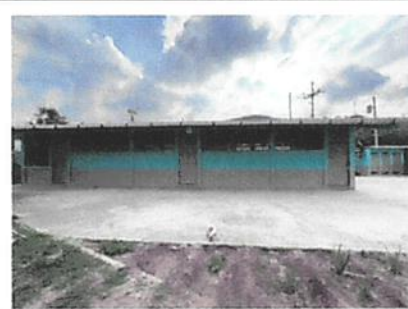
Foto 6: Pintura en muros exteriores e interiores
