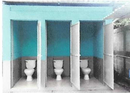
Foto 4: Sustitución de inodoros
