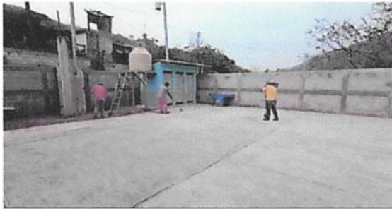
Foto7: Reparación de planchas de concreto de patio
