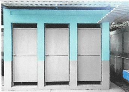
Foto 5: Mantenimiento a estructura (lijado, cambio de tubo , cepillado, aplicación de pintura ) a puertas de servicios sanitarios
